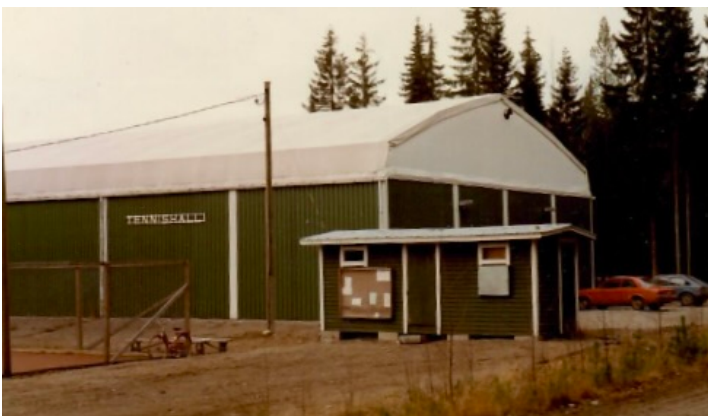
Uusi tennishalli ulkoa päin.
