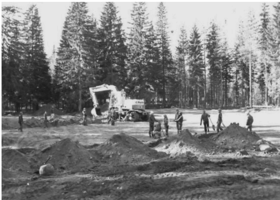
Kalevankankaan massakentän rakentaminen alussa
